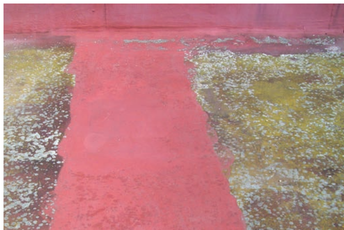
Zachovalý stav 19 leté střechy s nátěrem SANAKRYL TOP.
