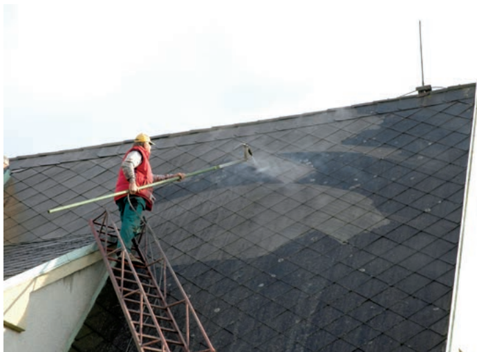
Očištění a odmaštění krytiny pomocí WAP.
