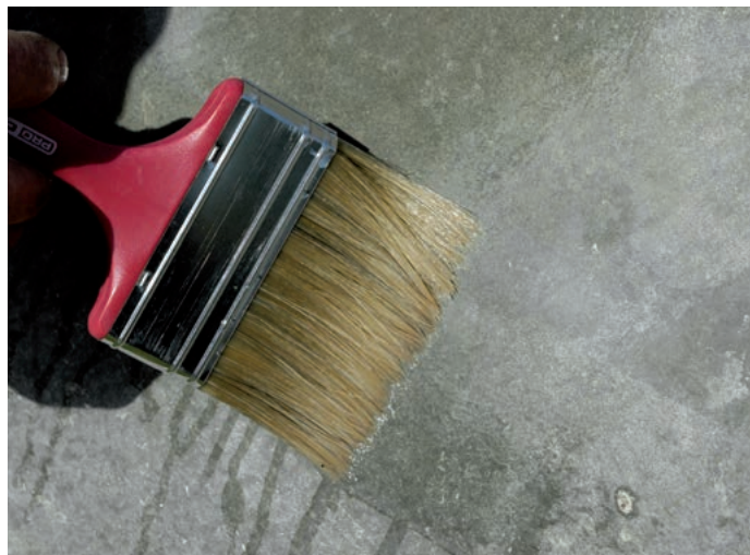
Penetrace krytiny penetračním prostředkem FORTE penetral .
